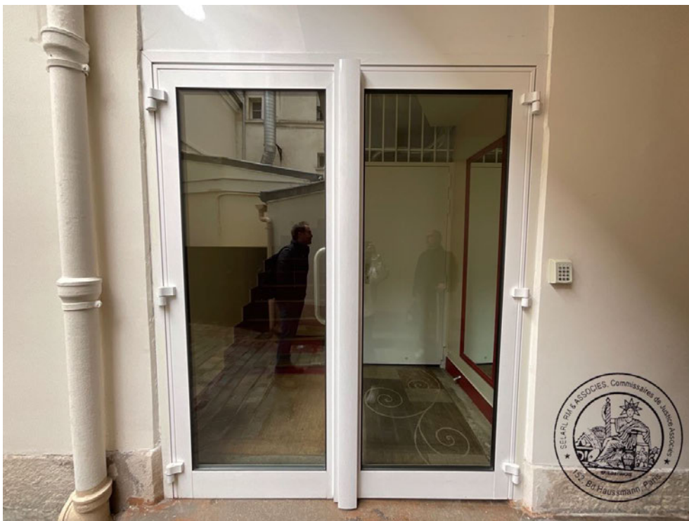
Accès immeuble au rez-de-chaussée dans la cour
