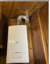
Photo no PhGaz002 Localisation: Cuisine Chaudière SAUNIER DUVAL (Type: Raccordé)
