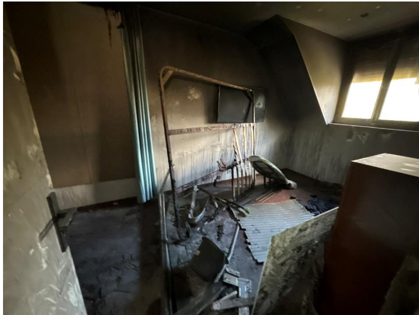
Une petite salle d'eau est attenante et il s'agit d'une pièce qui bénéficie d'une aération naturelle, exposition Nord.
