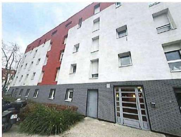
L'accès est sécurisé.
