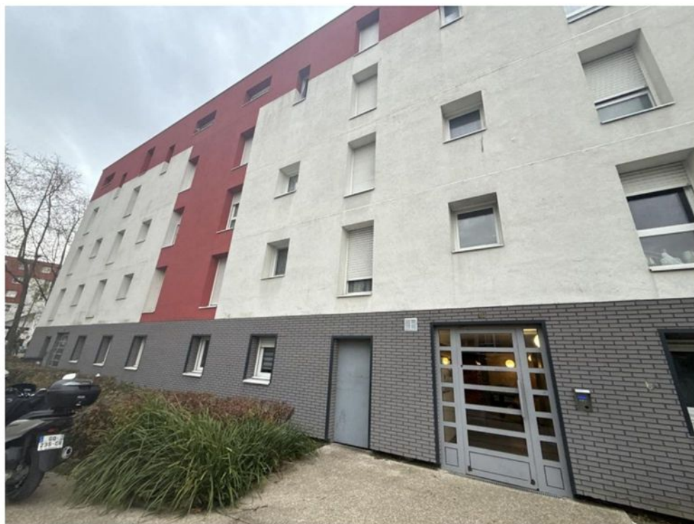
L'accès est sécurisé.
